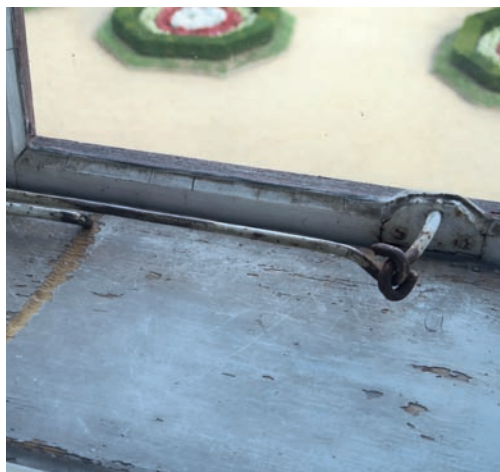
Obr. 78: Klasický okenní hák, v 19. století měly okenní háky v některých případech další mezičlánek umožňující jejich estetičtější složení při zavřeném okně, zámek Libochovice (okres Litoměřice).
