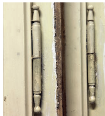
Obr. 17: Hölzerovy zapuštěné závěsy: a – pro dveře (vlevo); b – pro okna (uprostřed), se dvěma zakončeními – kuželem a žaludem (převzato z T. Hölzel, o. c. v pozn. 3, tab. 43, 44); c – zakončení kuželem s kuličkou (vpravo) bylo nejtýpčtější (NTM, sbírka stavitelství).
