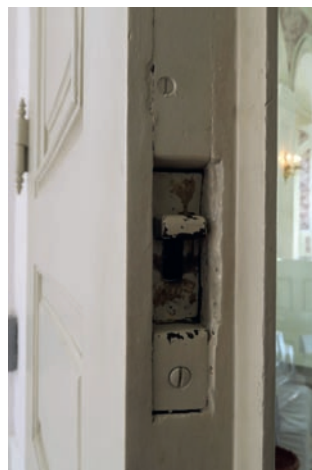
Obr. 36: Zapuštěná zástrčka, zámek Hubertusburg (Němcko).
