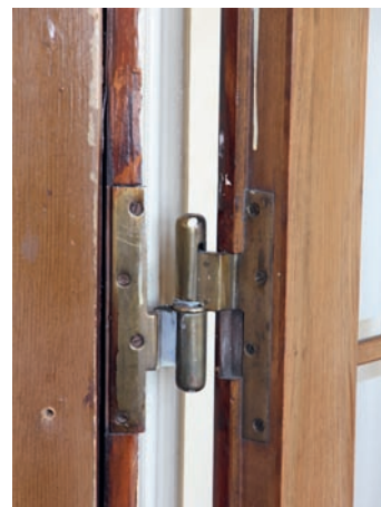
Obr. 18: Závěs lomený či odnášecí – různé varianty, nastupují však ve větším měřítku až na přelomu 19. a 20. století: a – vlevo dle Titschera 17) (převzato z F. Titscher, o. c. v pozn. 17. tab. 60); b – uprostřed závěs na okenici výkladce, aby se vyhnul bosáží, Libochovice (okres Litoměřice); c – vpravo závěs u interiérových skleněných dveří ze začátku 20. století v Desfourském paláci v Praze.
