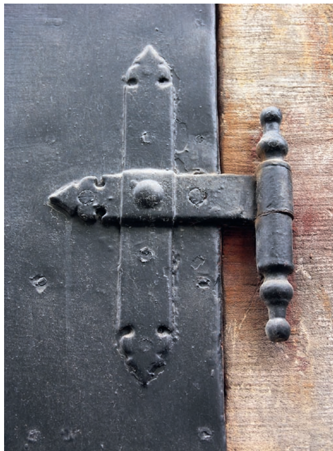
Obr. 5: Klasický křížový závěs na železných dveřích (foto J. Škabrada).
