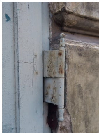
Obr. 18: Závěs lomený či odnášecí – různé varianty, nastupují však ve větším měřítku až na přelomu 19. a 20. století: a – vlevo dle Titschera 17) (převzato z F. Titscher, o. c. v pozn. 17. tab. 60); b – uprostřed závěs na okenici výkladce, aby se vyhnul bosáží, Libochovice (okres Litoměřice); c – vpravo závěs u interiérových skleněných dveří ze začátku 20. století v Desfourském paláci v Praze.
