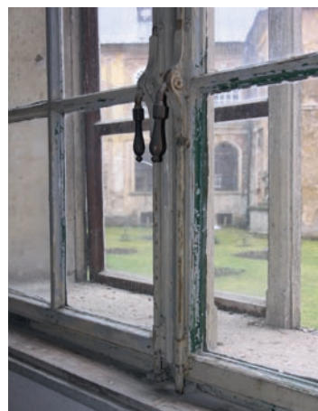
Obr. 47: Jednotyčové baskulíky s vesly v klášteře Teplá (okres Cheb) (foto J. Škabrada).
