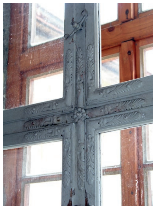
Obr. 71: Křížový rohovník na sloupku s poutci a běžné rohovníky na křídlech okna na faře v Horním Maršově (okres Trutnov) (foto J. Škabrada).
