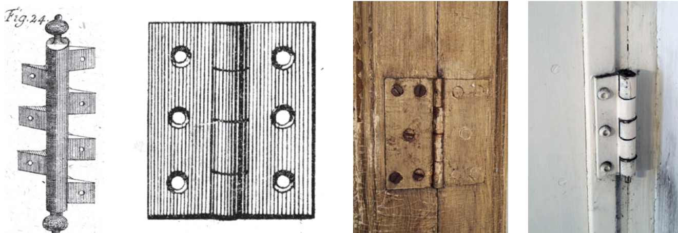
Obr. 22: Duhamelova (francouzská) práce prezentuje závěsy či stěžejky: a – jako závěsy pro těžká vrata (převzato z H-L. Duhamel du Monceau, o. c. v pozn. 4, tab. 13, č. 2), v českých zemích se s tímto využitím nesetkáváme; b – uplatňovaly se však například u drobných dvířek v tapetových stěnách, které neměly být patrné (M. Oehm, o. c. v pozn. 13, s. 88, č. 71); c – dveře prosklené stěny z konce 19. století, zámek Libochovice (okres Litoměřice); d – příklad použití z brněnské vily Tugendhat.
