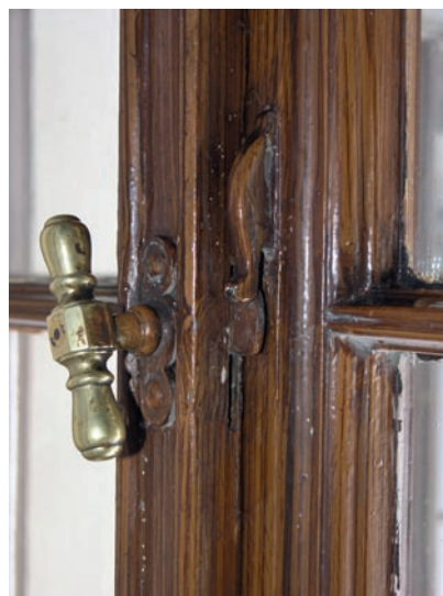
Obr. 45: Z kloubové rozvory (tj. baskulíku) byla prakticky viditelná jen klička, která mohla mít řadu variant, vlastní rozvora je skryta v českých zemích pod klapačkou. Zde je v kombinaci se zapuštěným obrtlíkem, Praha, čp. 1009/I (foto J. Škabradla).
