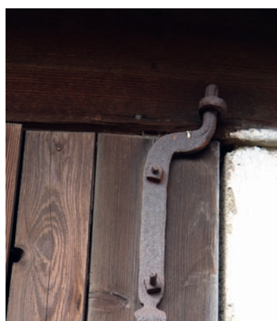
Obr. 20: Vrata stodoly v Kamenném Sedlišti (okres Svitavy), kde je čep mimo osu točnice (foto J. Škabrada).
