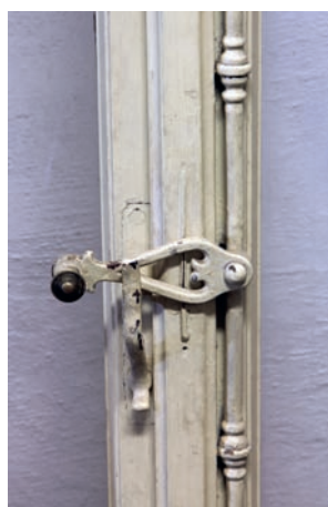
Obr. 38: Okno s přívorou – españoletou: a – celek; b – detail vesla (NTM, sbírka stavitelství).
