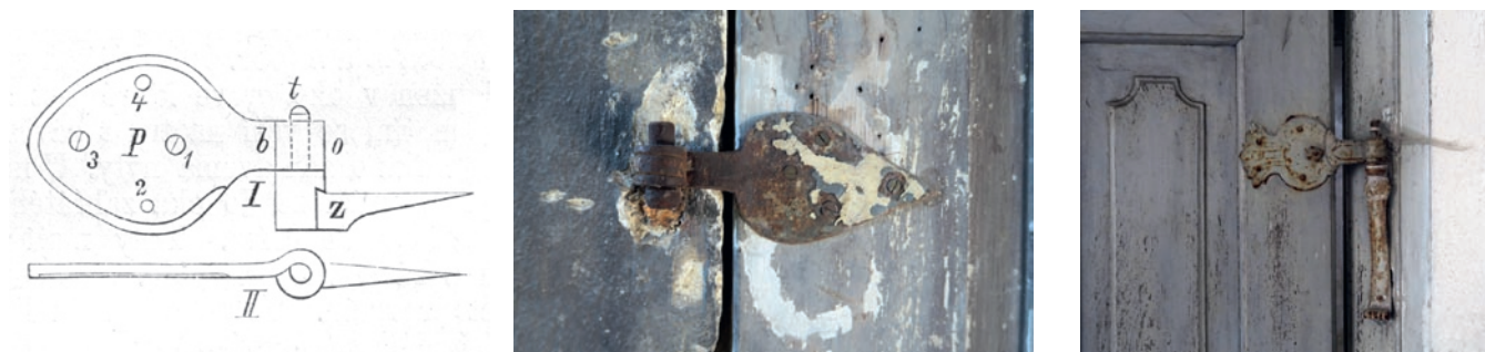
Obr. 11: Klasický lopatkový závěs se závěsníkem bez opěradla: a – pro dveře (převzato z A. O. F. Večeř, o. c. v pozn. 12, s. 29, obr. 55); b, c – lopatkové závěsy na zámčích Jezeří (okres Most) a Stvolínky (okres Česká Lípa).
