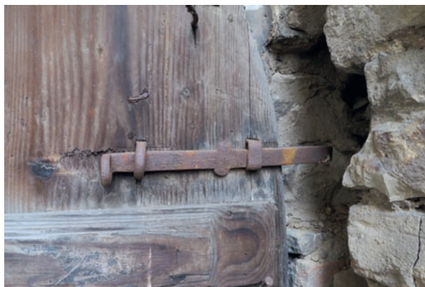
Obr. 32: Nejjednodušší typ nasazené zástrčky u dvoukřídlých dveří, kde byly obvykle párově: a – nahoře (převzato z H-L. Duhamel du Monceau, o. c. v pozn. 4, tab. 13, obr. 45) a b – dole (převzato z A. O. F. Večeř, o. c. v pozn. 12, s. 37, č. 85); c – mezi tyto zástrčky náleží i nejjednodušší utilitární typy – Žatec (okres Louny) čp. 102.
