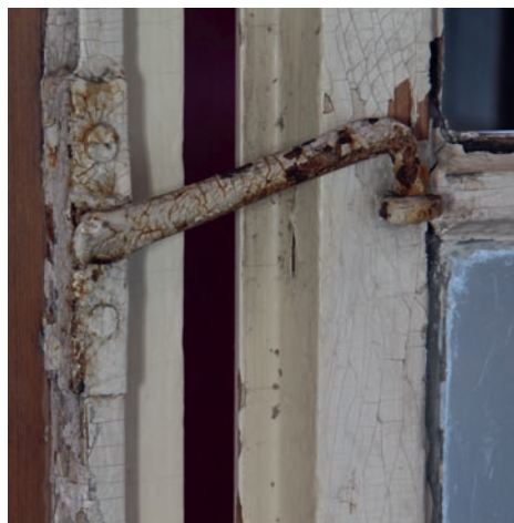
Obr. 77: Malý okenní hák na rám okna zajišťující otevřené okno (NTM, sbírka stavitelství).
