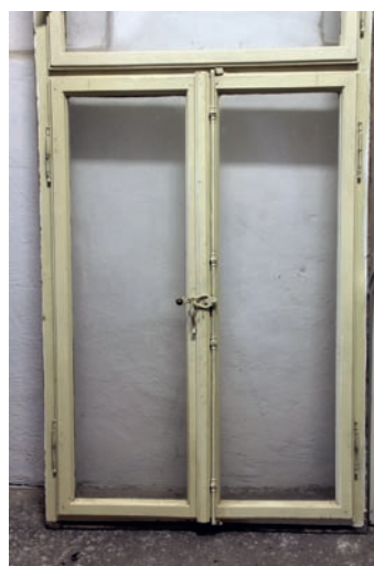
Obr. 38: Okno s přívorou – españoletou: a – celek; b – detail vesla (NTM, sbírka stavitelství).
