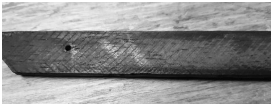
Zadní strana nepůvodní vlnité lišty prozrazuje řez kotoučovou pilou. © Jan Hrdina.
