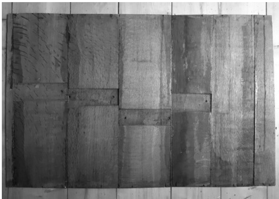
Vnitřní strana zad složená z druhotně použitého materiálu. © Jan Hrdina.
