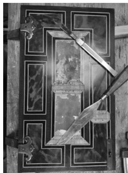
Demontáž při restaurování odkryla čtvercové stopy po kovaných hřebících. © Jan Hrdina.
